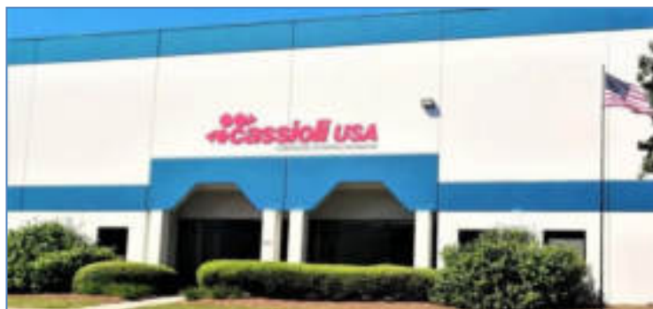
Figura 3 – Stabilimento di Newnan – Atlanta (USA)
